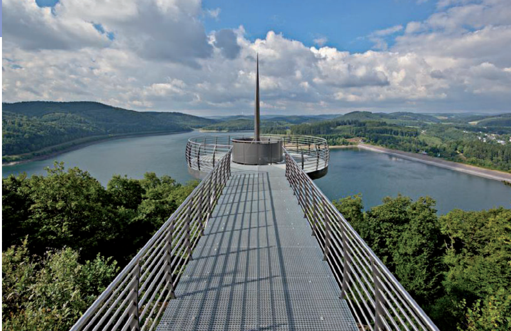
Metallbaupreisträger 2015 Kategorie „Stahlkonstruktionen“: die mit duroZINQ® vor Korrosion geschützte spektakuläre Aussichtsplattform (Skywalk) am Biggensee in Attendorn.
