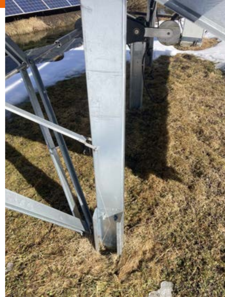
Detailaufnahme der Unterkonstruktion im März 2023. (© Albert Knotz)
