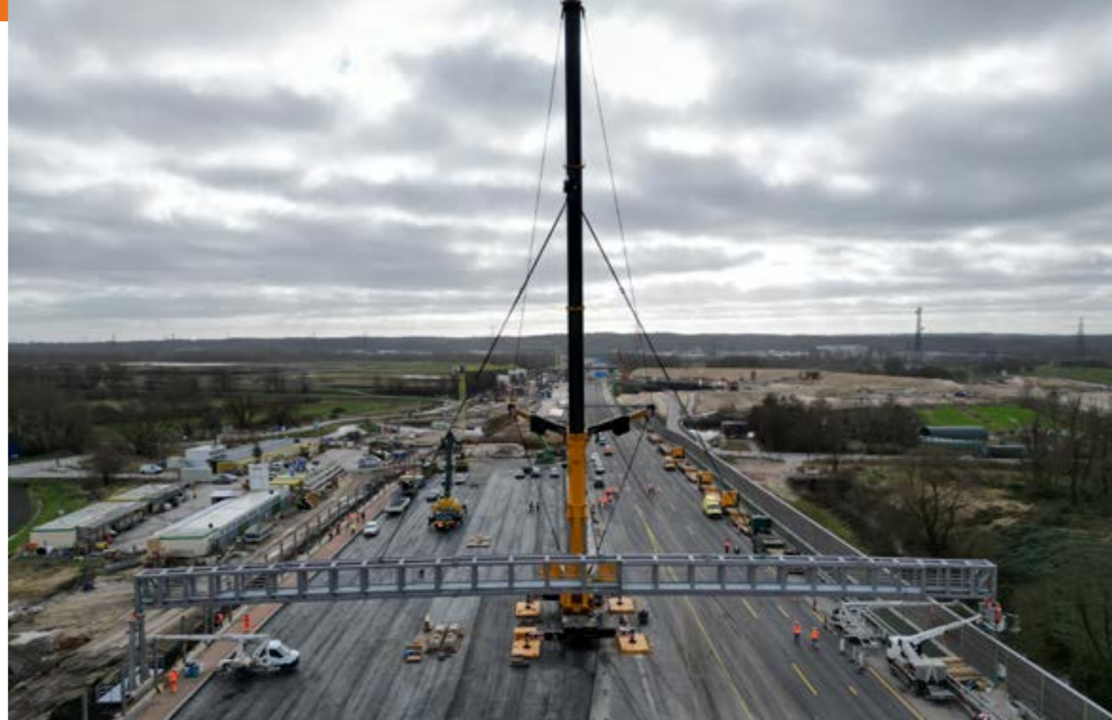
Installation der Schilderbrücke auf der A7.
